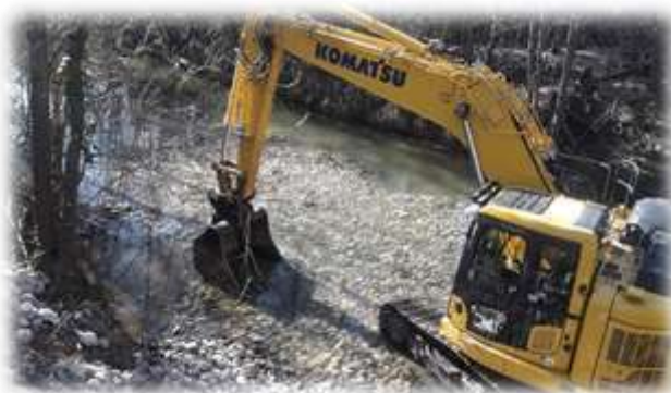
Figure 22 : Travaux de recharge sédimentaire à l'Isle en Dodon
