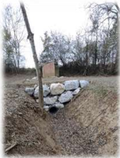
Figure 24 : Passage busé restauré
