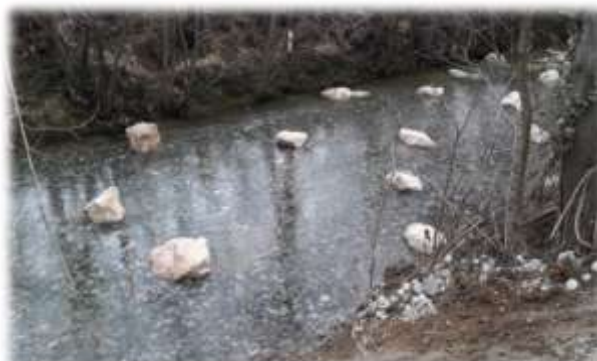
Figure 23 : Implantation de blocs isolés
