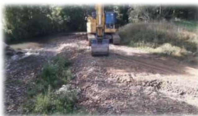
Figure 21 : Traitement de l'atterrissement
