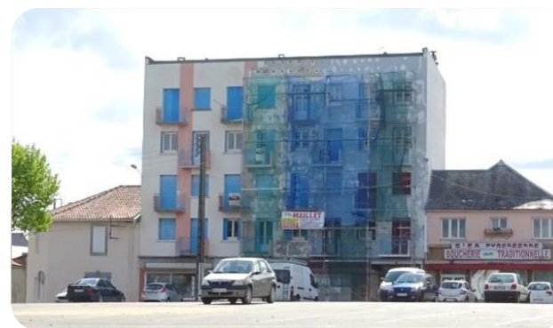
Rénovation d'un immeuble à Lannemezan © Even Conseil
