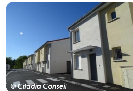
Nouvelles constructions de logements sociaux sur la commune de Lannemezan
