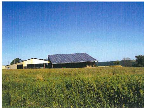
La possibilité de moderniser les élevages
